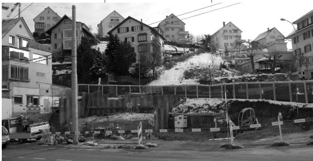
Vorbereitungsarbeiten beim Geissensteinring
